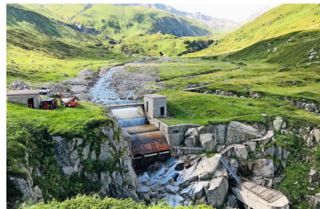
25 Meter tief im Untergrund unter dieser Wasserfassung der Unteralpreuss musste das 16 000-Volt-Kabel geflickt werden.
